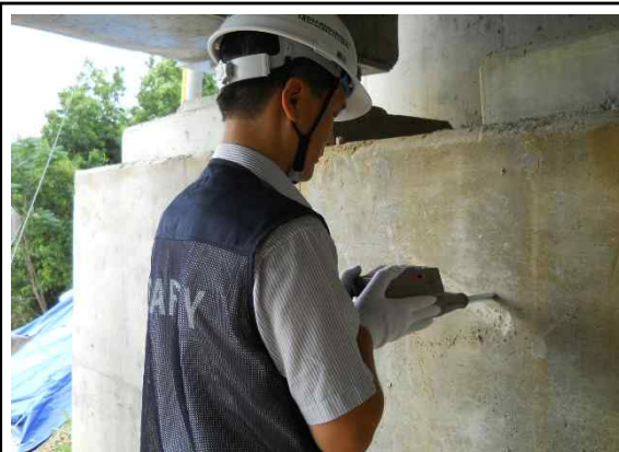
교대1 구체 전면 콘크리트 강도조사
