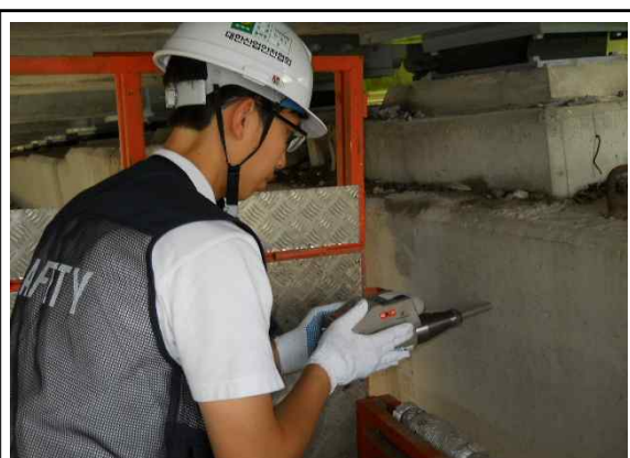
교각 코핑부 콘크리트 강도조사
