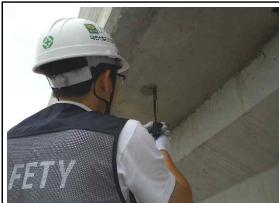
바닥판 하면 탄산화 시험
