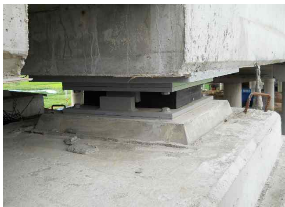
교좌장치 시공 상태
