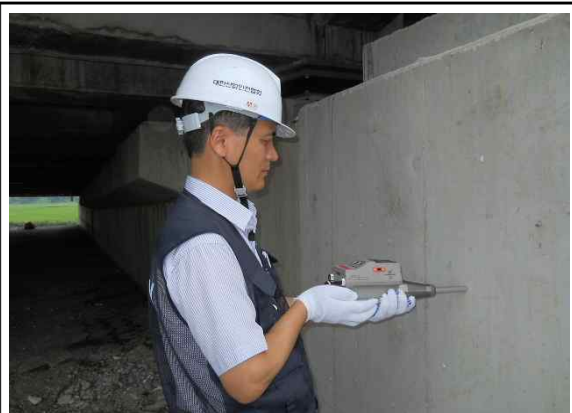
교대2 구체 전면 콘크리트 강도조사
