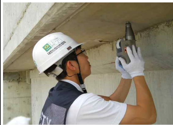
바닥판 하면 콘크리트 강도조사
