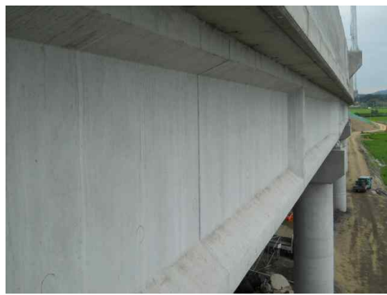
교량 거더 전경
