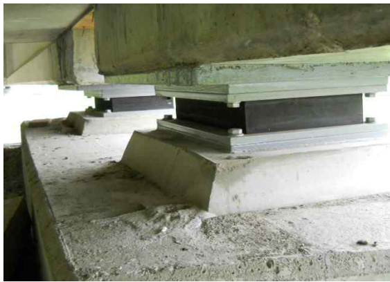
교좌장치 시공 상태
