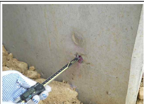
교대2 구체 전면 탄산화 시험
