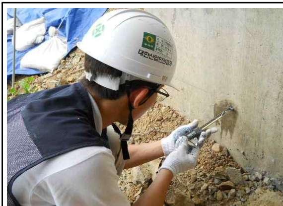
교대1 구체 전면 탄산화 시험
