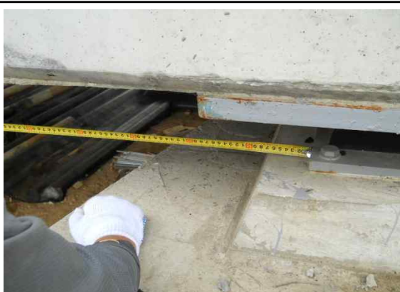
교각 교량받침 연단거리 측정
