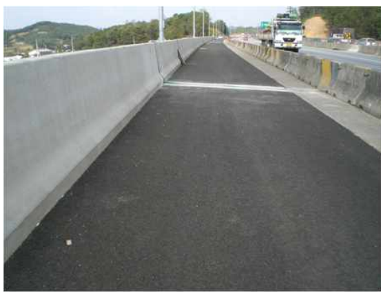
교량 상면 전경
