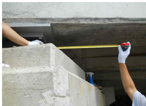
교대 교량받침 연단거리 측정
