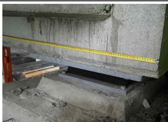
교각 교량받침 지지길이 측정
