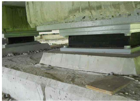
교좌장치 시공 상태
