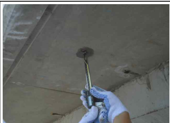
바닥판 하면 탄산화 시험
