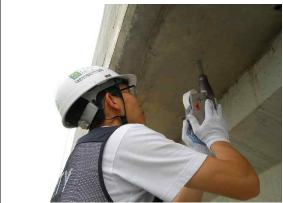
바닥판 하면 콘크리트 강도조사
